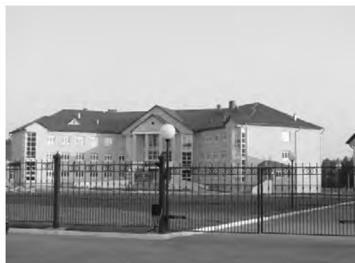
Новый больничный комплекс
